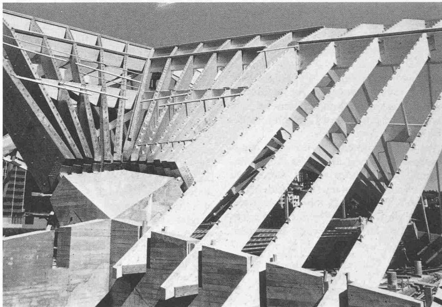
che sowie in der Mitte der unteren Restlänge angeordnet sind. Die über den Tribünen angeordneten Binder (Querschnitt: 18/115 cm) weisen Längen zwischen 14,6 m und 20,7 m auf. Die tragenden Abstützungen – bei den Sitzplatztribünen Stahlstützen, bei den Stehplatztribünen Holzstützen mit einer Diagonale unter dem First – sind in den zusätzlichen Fundationen verankert, wobei die Anordnung von Nebenräumen und Tribünen die Grundrisslage der Stützen bestimmte.
