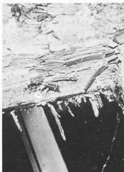
Bild 3. Durch den Balkenblättling ( Gloeophyllum trabeum Murrill) zerstörter Balkon
