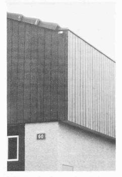
Bild 7. Fassadentäfer mit eingebauter Dachrinne
