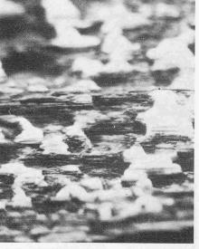
Oberflächliche Holzerosion durch Solarstrahlung, Bläuepilze und Regen
