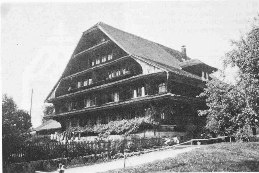
Bild 10. Konstruktiver Holzschutz an einem 200-jährigen Luzerner Bauernhaus
