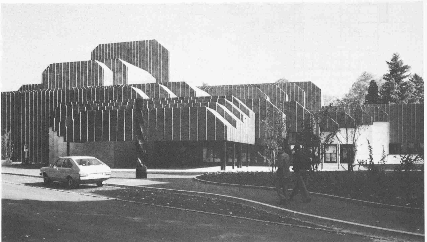
Blick zum Haupteingang
