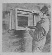
arbeiten. Das im ACO-Polyesterbetonrahmen eingesetzte stabile Sessa-Norm-Metallfenster ist mit einer Kittfuge gegen Regen und Wind abgedichtet. ACO Sessa ist ein einbaufertiges Leibungsfenster mit hohem Finish. Dank der Handlichkeit und des geringen Gewichts - die Ele-
