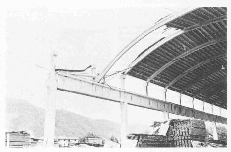
Schäden an einer Lagerhalle in Magnano als Folge des Friaul-Erdbebens vom 6. Mai 1976. Das äusserste Dachsegment ist vollständig heruntergestürzt. Der zweite Dreigelenkbogen fiel nur bis auf den Längsträger hinunter. Der Schaden ist primär durch die knappen Auflager der Dachelemente bedingt
