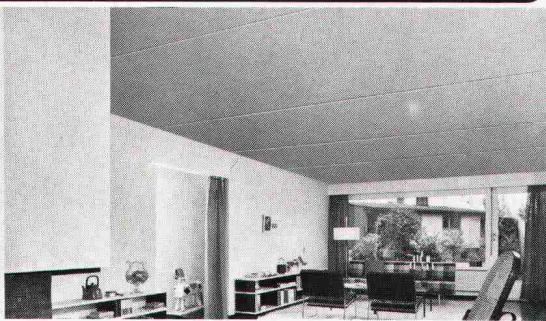
PRELAM-Deckenplatten sind grossflächige, vorfabrizierte Deckenelemente, welche die Funktionen der Schalung, der Hauptarmierung und des Verputzes übernehmen.
