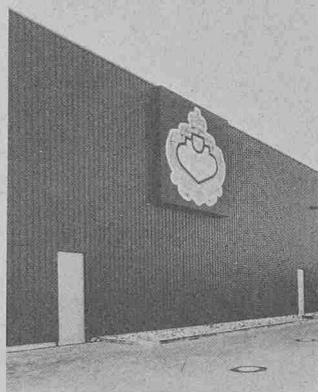
Thyssen-Thermowand. Typ VT 66 ( k = 0,559 W/m 2 K)
