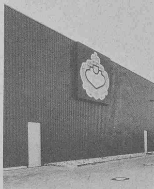
Thyssen-Thermowand. Typ VT 66 ( k = 0,559 W/m 2 K)
