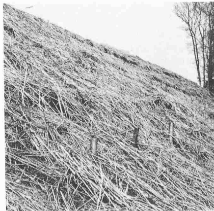
Bild 15. Kerzers N1, Mühle Grau. Die geschüttete Kiesböschung wurde mit Steckhölzern vernagelt, hinter welche Weidenstämme gerollt wurden; die Fläche wurde mit Schilf abgedeckt. (Stabilbauweise)
