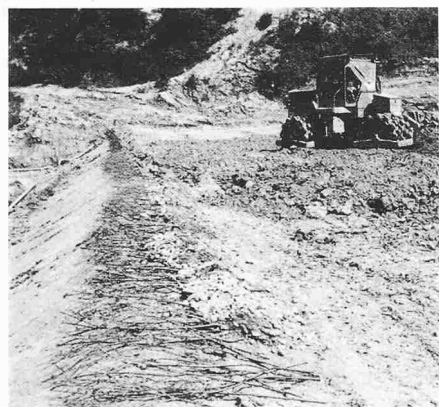
Bild 3. Salzweid N1. Auf ein rückwärts geneigtes Planum wurden Weiden und bewurzelte Pflanzen ausgelegt und darüber weitergeschüttet. (Stabilbauweise)
