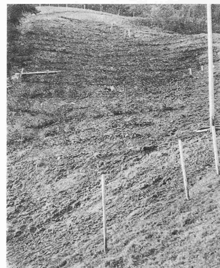
Bild 10. Schlupf, mit Buschlagen verbaut und dazwischen aufgeforstet. (kombinierte Bauweise)
