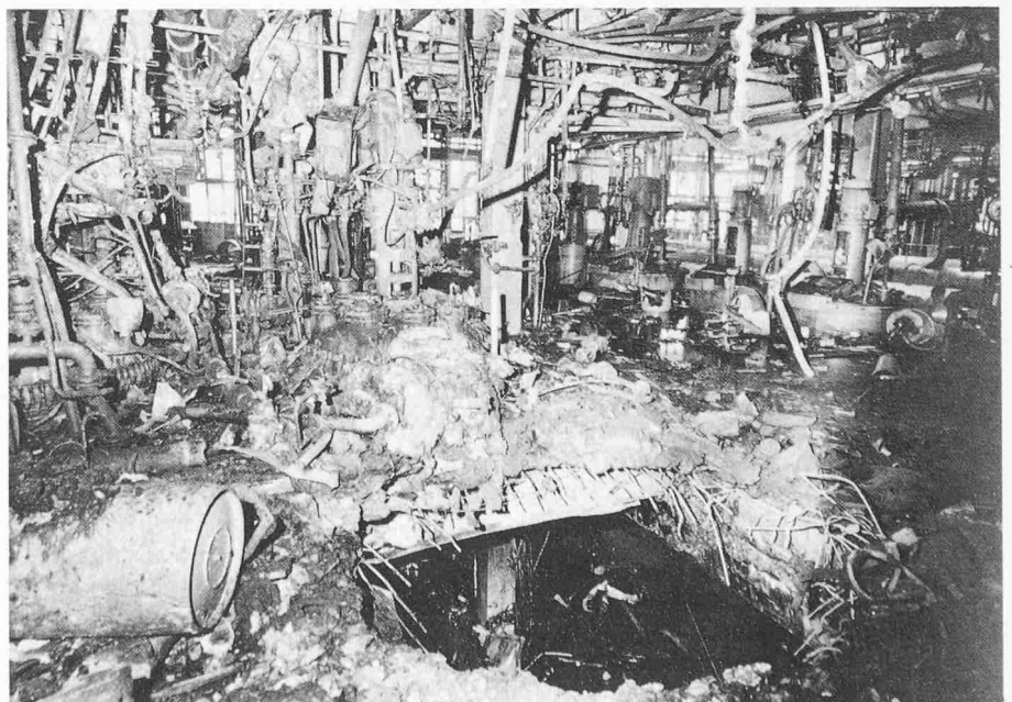
Bild 1. Explosion in einem Chemiewerk. Die Wucht der Explosion zerriss auch die armierte Betondecke
