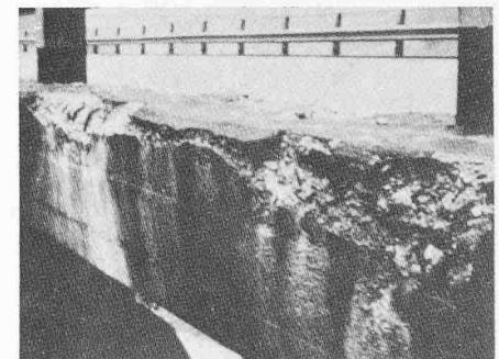
Bild 2. Tiefergehende Betonschäden an Kordonaussenseite. Armierungsseisen sind freigelegt
