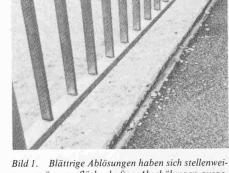
se zu grösseren flächenhaften Abschälungen ausgeweitet. Vorfabriziertes Randbordelement aus BH 300 mit Dichtungsmittel. 1 Jahr nach Inbetriebnahme, 3 Jahre nach Erstellung
