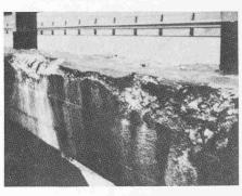
Bild 2. Tiefergehende Betonschäden an Kordonaussenseite. Armierungseisen sind freigelegt
