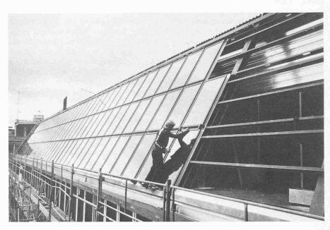
Das Sonnenkollektorenfeld für die Brauchwasserheizung auf dem westlichen Gebäudetrakt. Die Kollektoren bilden gleichzeitig die Dachhaut
