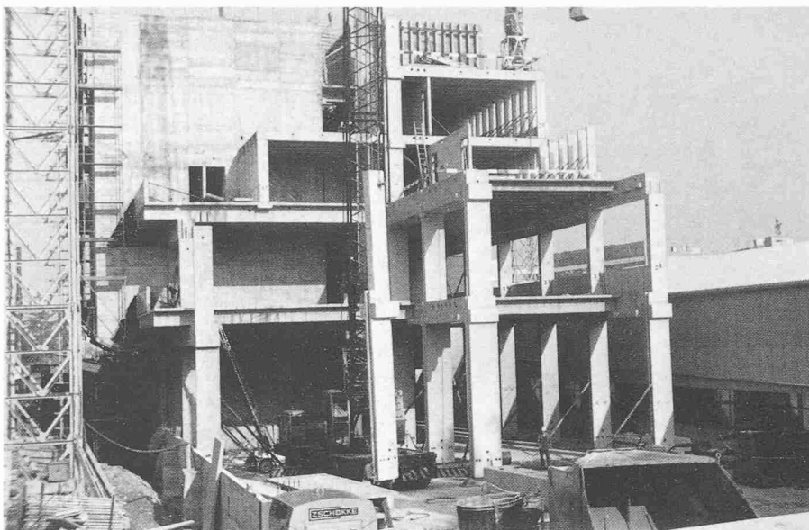
Montage des östlichen Traktes. Auch die Zwischenwände mit den Türzargen sind vorgefertigt
