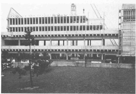
Links: Errichten der vorfabrizierten Betonkonstruktion über die vier Geschosse, von Westen beginnend. – Rechts: Ansicht des westlichen Gebäudetraktes, Vorfabrikation, Anschluss an den in Ortbeton ausgeführten Kern
