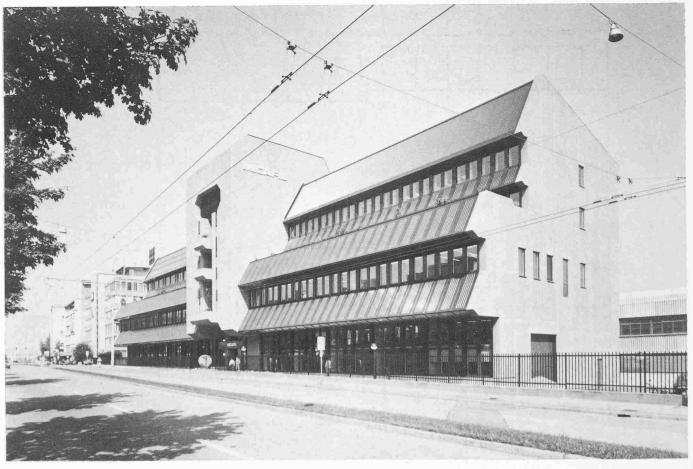
Gesamtanlage von Südosten. Auf dem westlichen Trakt im Dachgeschoss befinden sich Sonnenkollektoren, auf dem östlichen Teil besteht die Möglichkeit, für den späteren Einbau weiterentwickelter Kollektoren. In den Brüstungen des 1. und 2. Obergeschosses erkennt man die Luftkollektoren
