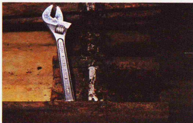
Bild 12. Geöffnete Überlappung mit Überresten eines Dichtungsbandes. Sehr starke Korrosion bis zur Perforation im Bereich der Überlappung
