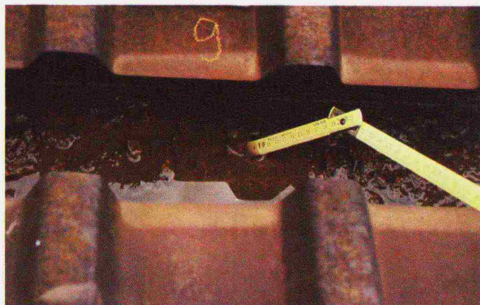
Bild 13. Dachrinne mit zu geringem Gefälle, fast vollständig angefüllt mit Wasser und schlammartigen Korrosionsprodukten
