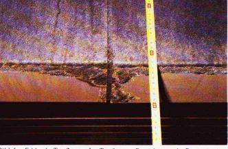
Bild 4. Fehlende Tropfkante. Im Tropfwasser-Bereich entsteht Rost mit einer gröberen Struktur als auf einer frei bewitterten Fläche. Die hellen Ablagerungen bestehen zur Hauptsache aus Eisensulfat
