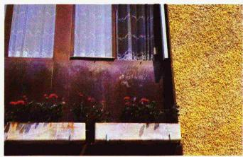
Bild 6. Fassadenelemente in Sandwich-Bauweise mit PUR-Schaumstoff als Wärmedämmung. Perforationen in der Bildmitte
