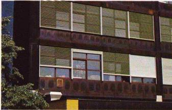
Bild 8. Unregelmässige Färbung von Fassadenelementen, verursacht durch un $terschiedliche\ W\"{a}rmeableitung\ (und\ damit\ unterschiedlich\ lange\ Feuchtperioden)$ an Stellen, wo im Elementinnern Stege als Abstandshalter angeheftet waren
