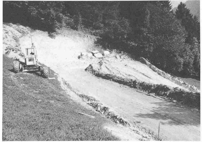
Bild 4. Ausbau der Strasse nach Ruen nach Panix. Ausweitung einer Wendeschleife oberhalb Ruen. Bauzustand: 11. Sept. 1979
