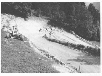
Bild 4. Ausbau der Strasse nach Ruen nach Panix. Ausweitung einer Wendeschleife oberhalb Ruen. Bauzustand: 11. Sept. 1979
