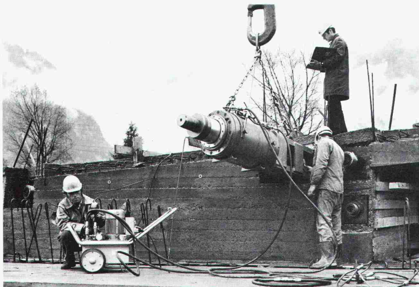
Spann- und Injektionsarbeiten werden durch Bauführer der STAHLTON AG überwacht, kontrolliert und protokolliert.
