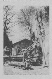
reich erstellt. Zum Errichten einer Grundwasserwanne im Felssturzgebiet musste man von unebenem Gelände etwa 1500 m2 in Flächensprengung abbohren, teils unter Wasser. Ausserdem wurde das wegzuräumende Gestein durch Sprengen zerkleinert, um bag-gerfähiges Haufwerk zu erhalten. An diesen Arbeiten war der
