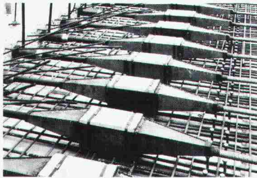
Vorfabrizierter Träger mit beweglicher Verankerung Typ A 2350
