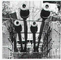
Hochbauträger, Kabel mit verschieblicher Kupplung Typ V 1400, 1. Teil
