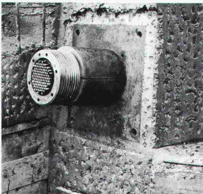
Brückenträger mit beweglicher Verankerung Typ M 4600
