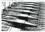
Fahrbahnplatte einer Stahlverbundbrücke mit Zwischenverankerungen Typ Z 630 und festen Kupplungen Typ  $\rm K_b$  630
