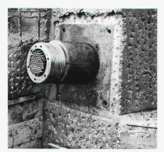
Brückenträger mit beweglicher Verankerung Typ M 4600
