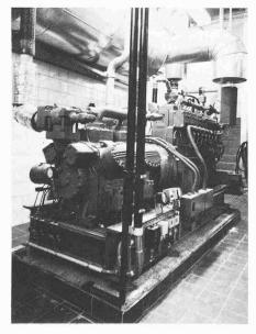
Bild 2. Gaswärmepumpenanlage im Freibad Dortmund-Wellinghofen
