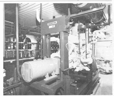
Bild 3. Gaswärmepumpe im Freibad Heilbronn
