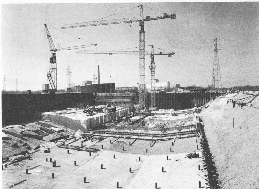
Bild 4. Blick in die Baugrube des 1. Bauabschnittes mit der Wehrsohle
