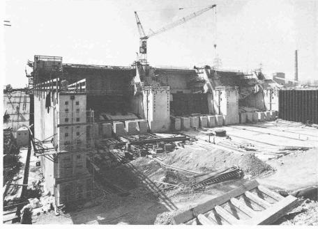
Ansicht des Staubalkenwehres, 1. Bauabschnitt
