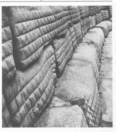
Bild 5. Mauerstruktur nach Entfernung von Hilfsschalung und Nylon-Gewebe
