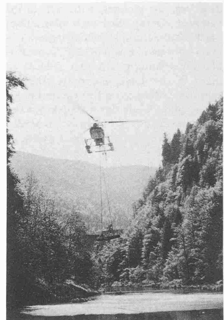
Bild 1. Unwegsame Gelände am Doubs
