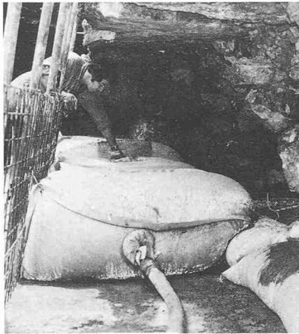
Bild 4. Injektionsvorgang mit anschliessendem Auffüllen des Hohlraumes hinter der Blockmauer
