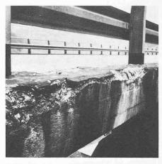
Tausalz- und Frostschäden am Brückenrand. Zerstörung des Brückenrandes durch Einwirkung von Frost und chemischen Auftaumitteln. Brücke über den Vorderrhein in Splügen, Höhe 1450 m, N 13c, Abschnitt Andeer-Hinterrhein. Baujahr: 1962. Die Instandstellung machte die Sanierung der Randeinfassung und die Anwendung einer Schutzabdichtung notwendig. Die Schäden sind 1978 behoben worden
