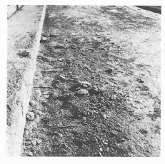
Bild 4. Frost- und Tausalzschäden des Fahrbahnbetons. Zustand der Betonbrückenplatte nach der Entfernung des Bitumenmörtelbelages.
