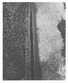
Bild 10. Zerstörung von Fugenübergängen durch Schneepflüge. Die im Belag vorstehenden Fugenübergänge werden von den Schneepfluglamellen beim Darübergleiten aufgespiesst. Die Fugen von zu leichter Bauart halten der wiederholten Beanspruchung während des Winterdienstes nicht stand
