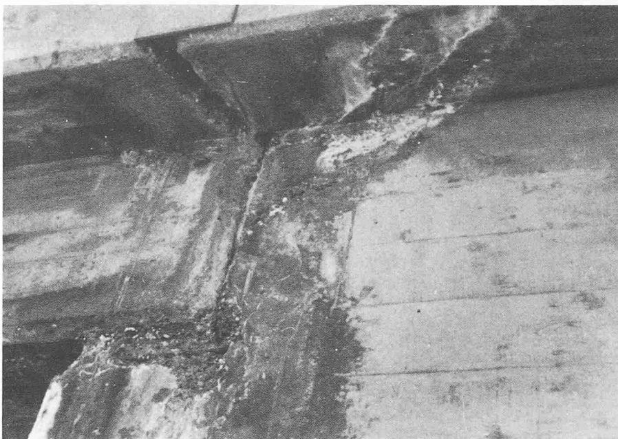
Bild 2. Beton-Tausalzschäden. Korrosionsbeispiel an Widerlagermauern eines Bauwerks infolge Frostwirkung und Einwirkung chemischer Aufbaumittel
