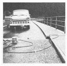
Bild 5. Widerlagerverschiebung. Die Schynstrasse durchquert zwischen Thusis und Davos mehrere instabile Hänge, so dass die Widerlager der Bauwerke in Zonen zu stehen kommen, die in Bewegung sind. Eine solche Widerlagerverschiebung wird durch die grosse Verschiebung - ca. 10 cm - zwischen den Randsteinen der Gehwege im Fugenübergang veran-
