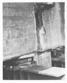
Beschädigtes Gerbergelenk. Die Gerbergelenke des gleichen Bauwerks wurden ausserdem durch das Eindringen von Oberflächenwasser, das durch den undichten Fugenübergang in das Rohrleitungswasser gelangte, schwer beschädigt. Brücke von Crestawald in Sufers, Höhe 1400 m,
