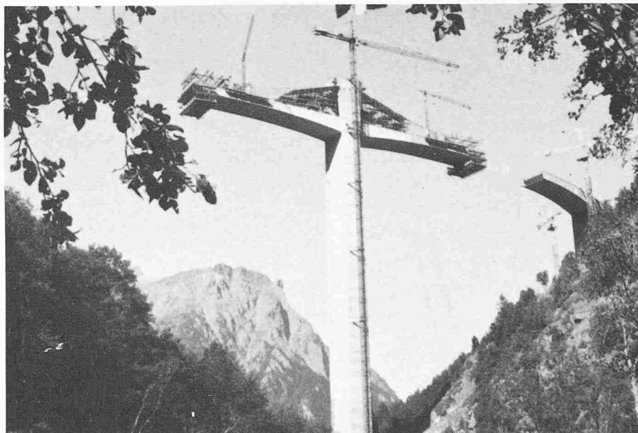
Bild 4. Freivorbau auf Pfeiler S3. Bauzustand August 1979
