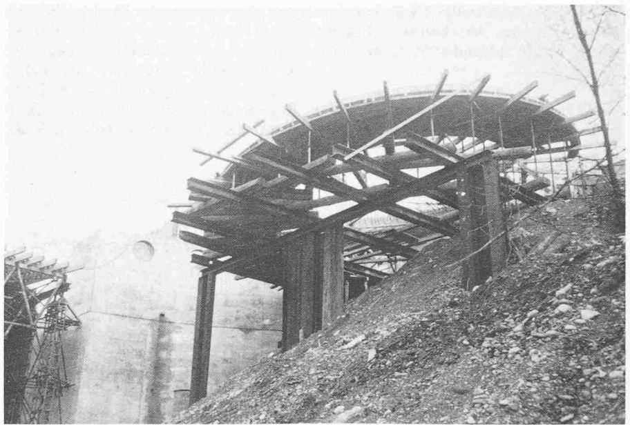
Bild 9. Einrüstung einer Spiralrampe
