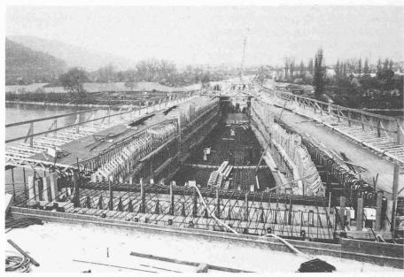
Bild 11. Trog während Schalungs- und Armierungsarbeiten
