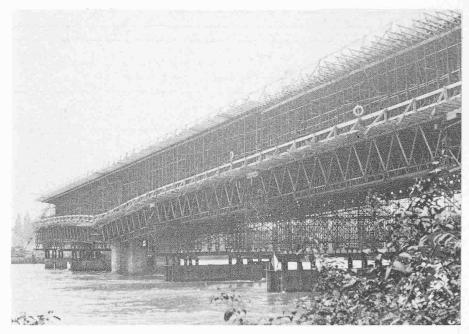
Bild 10. Lehrgerüst des 1. Bauabschnittes
