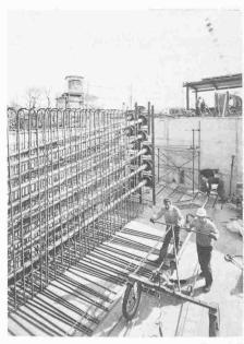
Bild 8. Endverankerung der 4600 kN-Längskabel
