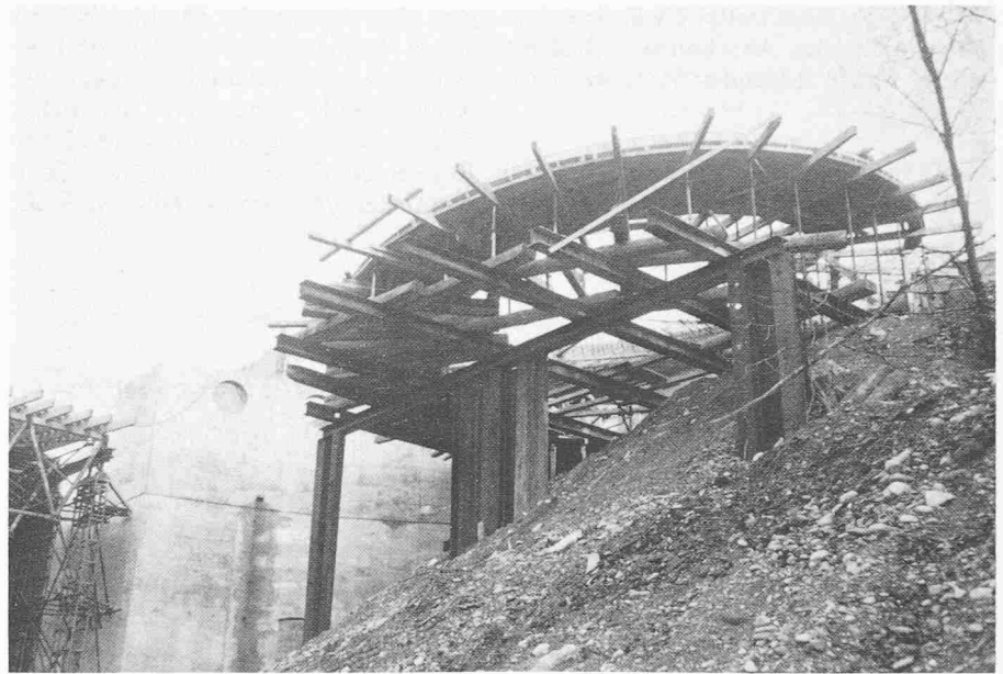
Bild 9. Einrüstung einer Spiralrampe
