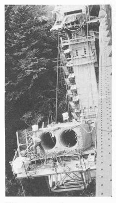
Bild 3. Bogen betoniert, Abspannung
