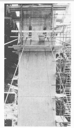
Bild 6. Umlenkung der Kabelkräfte
