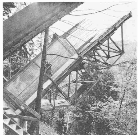
Bild 2. Grundetappe mit Vorbaugerüst
