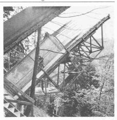
Bild 2. Grundetappe mit Vorbaugerüst
