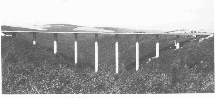
Elztalbrücke (1965). Spannbeton-Pilzkonstruktion mit Vorschubgerüst
