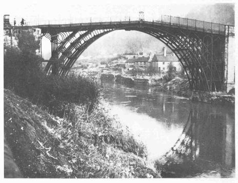
Coalbrookdale-Brücke (1779), erste eiserne Brücke über den Severn in England
