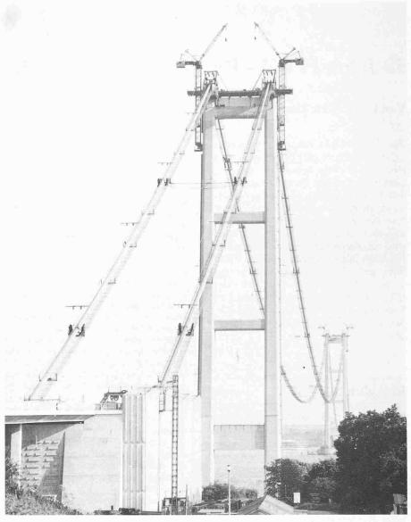
Humber-Brücke (1979 im Bau), England, Spannweite 1410 m
