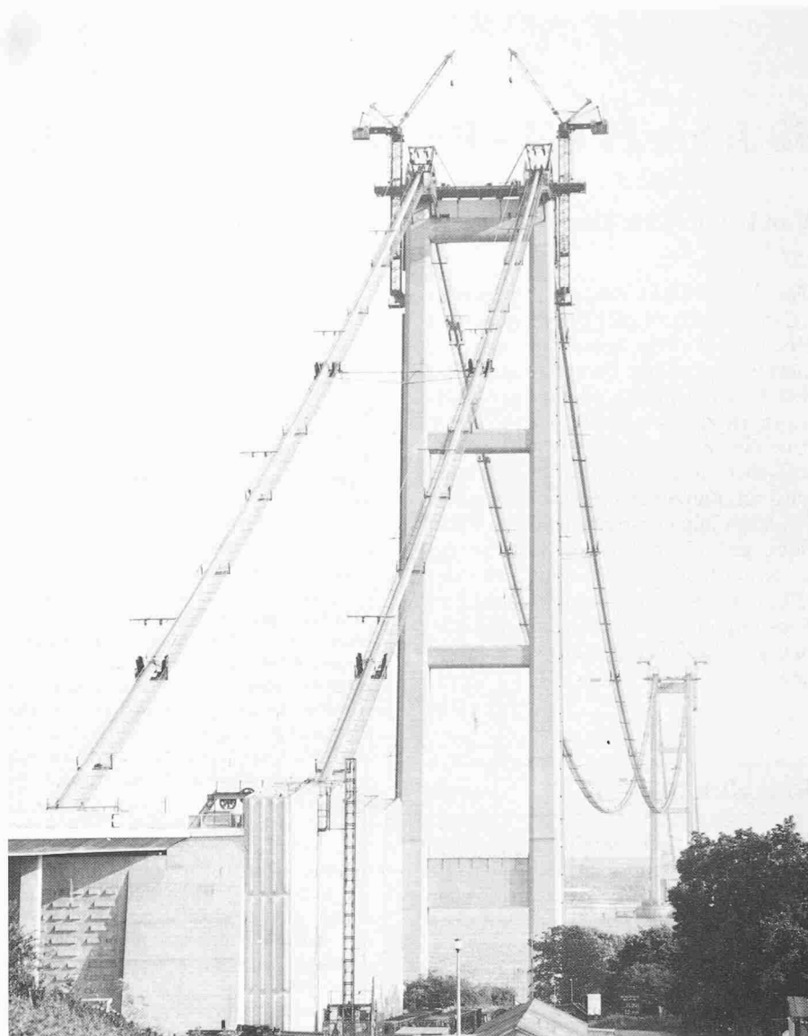
Humber-Brücke (1979 im Bau), England, Spannweite 1410 m
