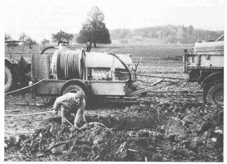
Bild 1. Spülung eines Saugers vom aufgegrabenen Anschluss her mit «Barth-Holland Dränspülgerät L 90». Wasserzufuhr mit Druckfass und aufgebautem Tank an Unimog
