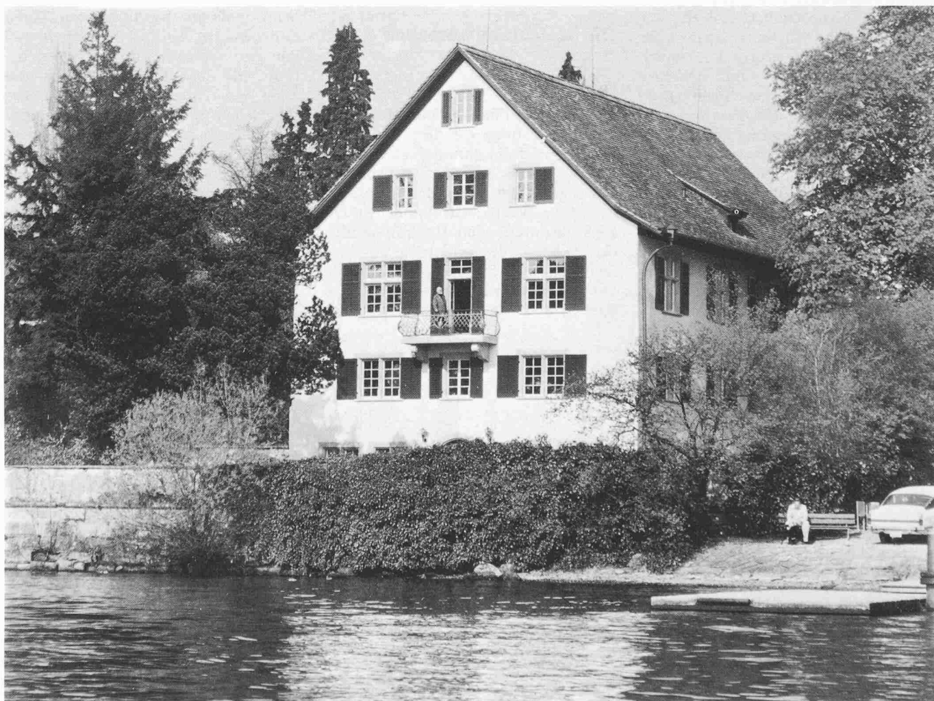
Der Seehof in Küsnacht nach der Restauration, ein baugeschichtlich bedeutendes Patrizierhaus am Zürichsee
