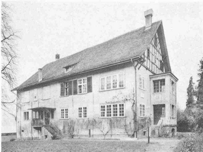
Südost-Ansicht vor der Restaurierung
