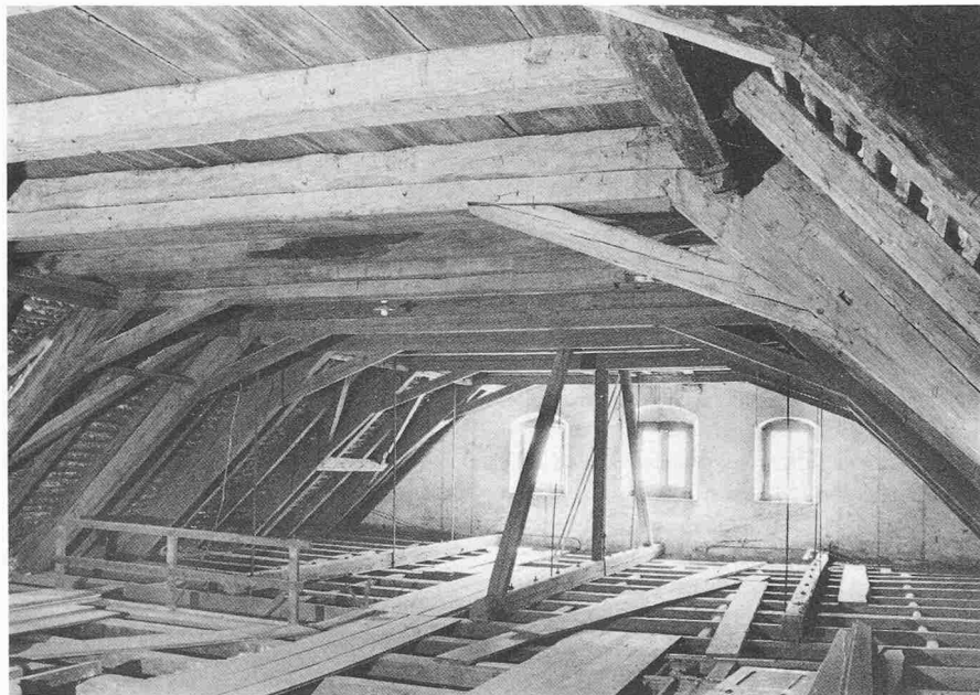
Liegender Dachstuhl mit Sprengwerk
