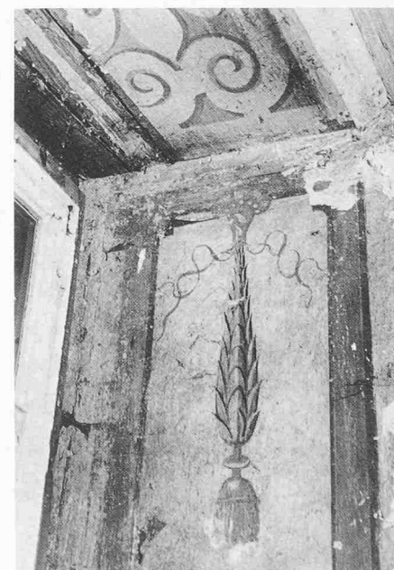
Fachwerkzimmer im Hochparterre: Detail Fensterumschne vor der Restaurierung
