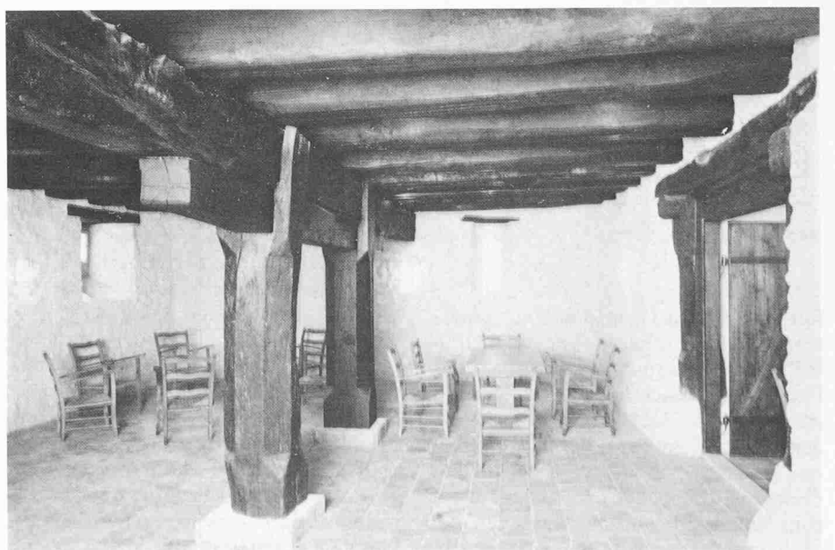
Der grosse Keller – ein Raum mit mittelalterlichem Gepräge
