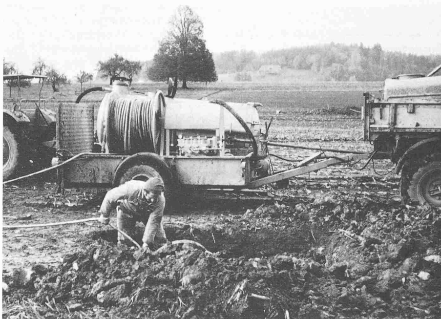
Bild 1. Spülung eines Saugers vom aufgedrungenen Anschluss her mit «Barth-Holland Dränpülgerät L 90». Wasserzufuhr mit Druckfass und aufgebaumem Tank an Unimog
