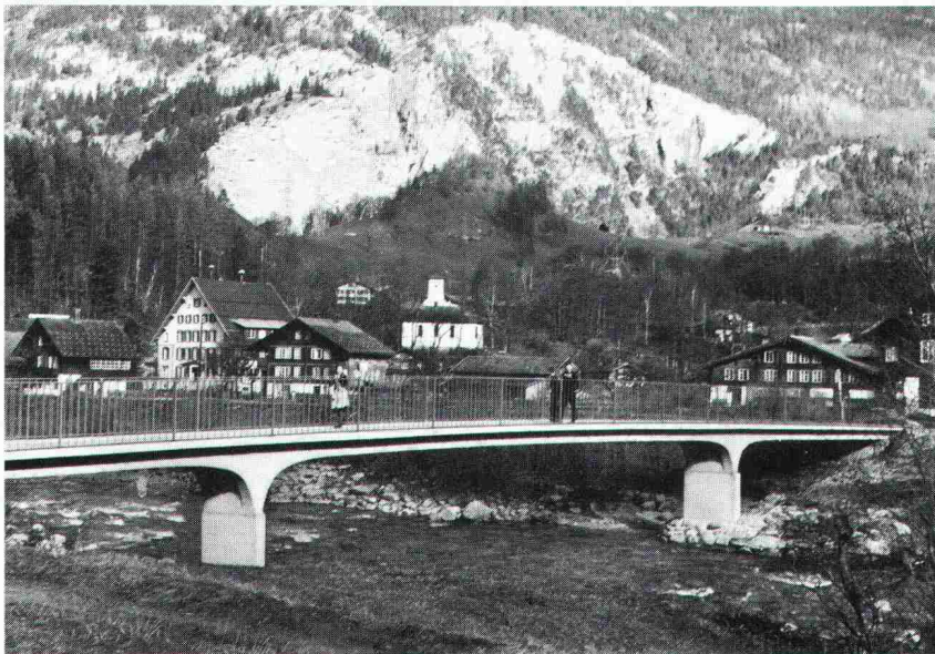
Aaresteg in Innertkirchen, erbaut 1951. BBRV-Spannkabel beweisen ihre Dauerhaftigkeit seit nahezu 30 Jahren in 6000 Bauwerken in der Schweiz und in Zehntausenden auf allen Kontinenten.
