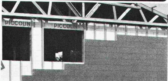
Hochwertiger Glasfaserbeton in der Fassadenausführung «standard» oder «nach Mass». Die hinterlüftete CEMFOR-Fassade setzt neue Massstäbe: Ausserordentlich widerstandsfähig gegen Beschädigung und alle Witterungseinflüsse • Formstabil
