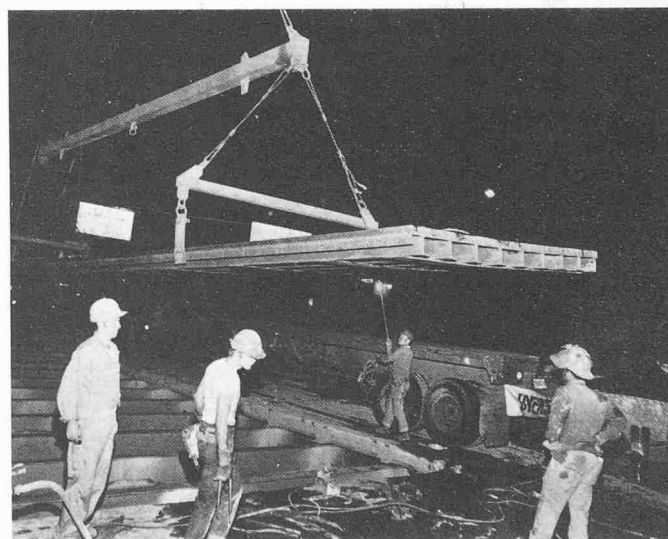
Der Einbau der verstärkten Stahlplatten mit dem Fahrbahnbelag erfolgt in Einheiten von ca. 3×18 m
