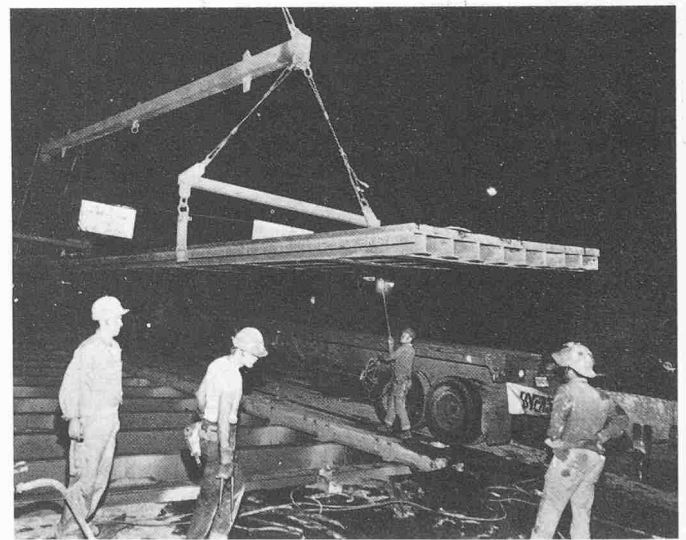
Der Einbau der verstärkten Stahlplatten mit dem Fahrbahnbelag erfolgt in Einheiten von ca. 3 \times 18 m
