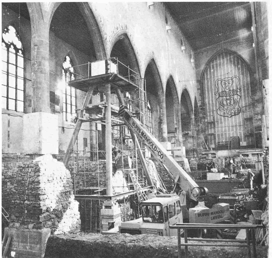
Bild 8. Pfeiler B 4 ist unterfangen und bis auf das Fundament abgetragen. Im Gegensatz zu den Pfeilern der Achse C ruhten diejenigen der Achse B auf massiven Einzelfundamenten. Im Hintergrund erkennt man die provisorische Schutzwand zwischen Chor und Mittelschiff (Aufnahme 29.1.76)
