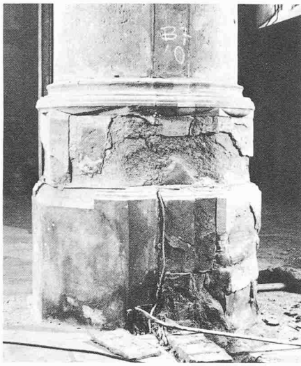
Bild 3a. Pfeiler B 7. Die «elektro-physikalische Mauertrockenlegung» hat die Zerstörung des Steingefüges nicht verhindern können (Aufnahme: Mai 1975)
