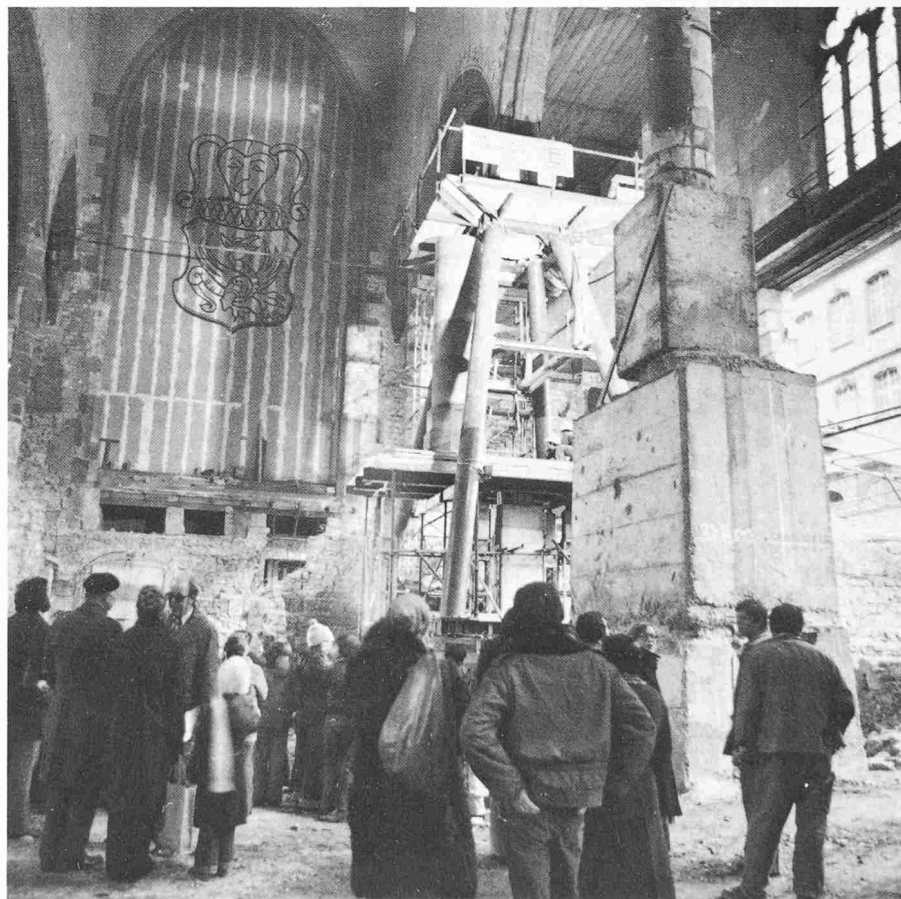
Bild 12. Pfeiler C 7. Der neue Buntsandstein-Pfeiler ist seitlich mit Hilfe eines Pneu-kranes zusammengebaut worden; nun wird er unter die Trennfuge eingefahren. Eine Schulk-klasse schaut interessiert zu (Aufnahme: 16.12.76)
