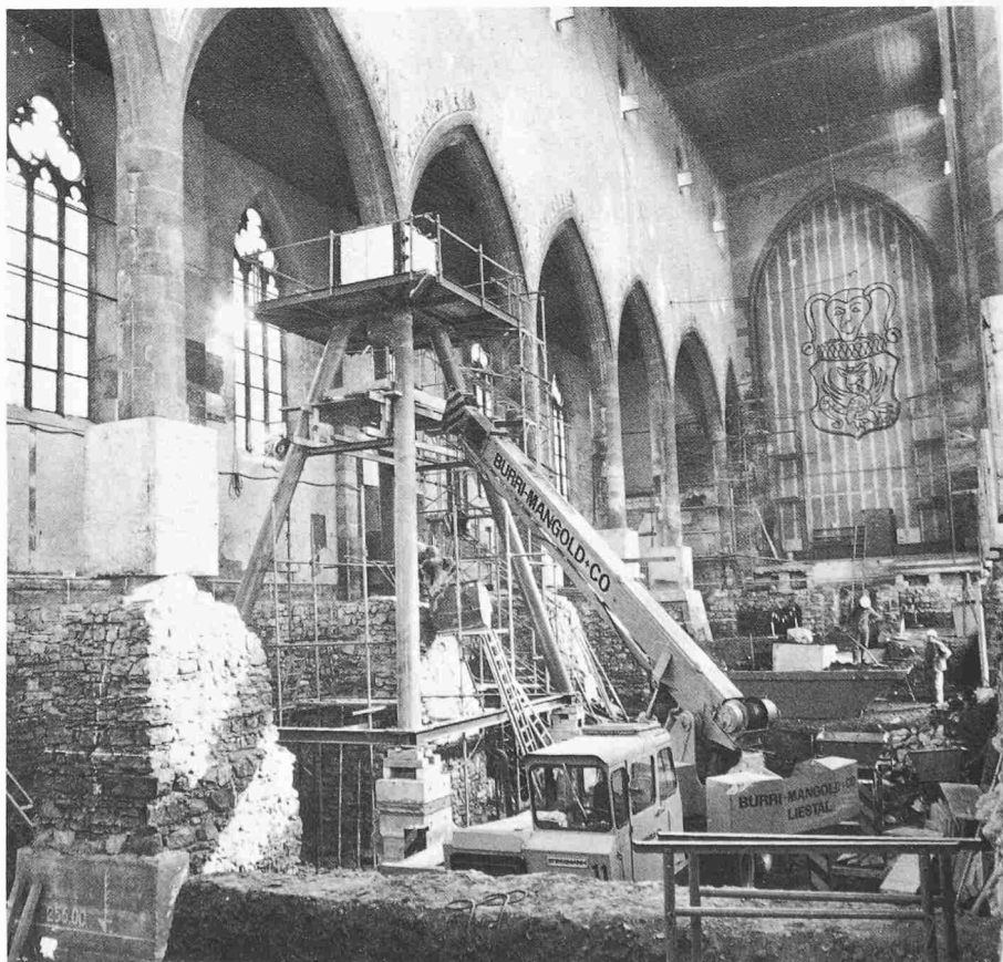
Bild 8. Pfeiler B 4 ist unterfangen und bis auf das Fundament abgetragen. Im Gegensatz zu den Pfeilern der Achse C ruhen diejenigen der Achse B auf massiven Einzelfundamenten. Im Hintergrund erkennt man die provisorische Schutzwand zwischen Chor und Mittelschiff (Aufnahme 29.1.76)
