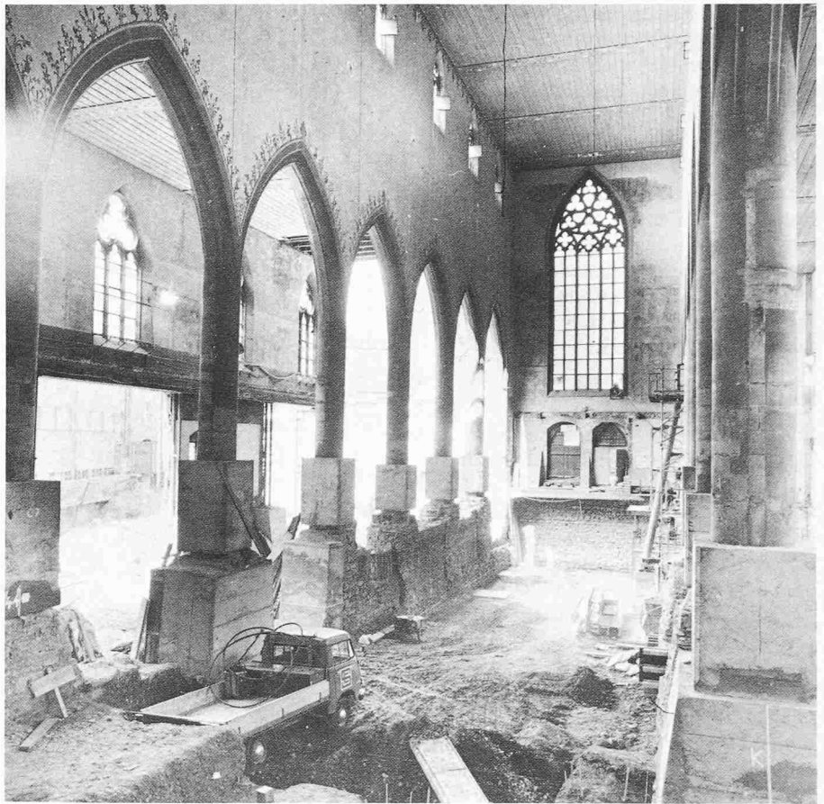
Bild 7. Das Untergeschoss ist ausgehoben. Links sieht man die freigelegte Grundmauer der Nordfassade der ersten Barfüsserkirche. Die Baumeister der zweiten Kirche haben sie als Fundament für die südliche Pfeilerreihe (Achse C) benützt (Aufnahme: 30.4.76)
