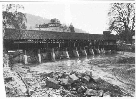
Umbau nahezu vollendet. Im Vordergrund liegen Blöcke der Sohlenpflästerung von 1818, eingebracht in der Flossgasse rechts aussen
