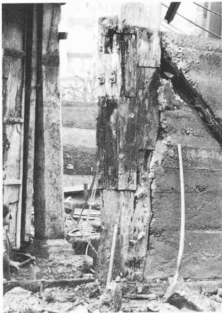
Wehrpfeiler 4/5 mit Flickarbeiten aus drei Jahrhunderten
