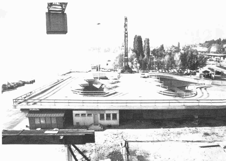
Bild 2. Verladerrampe. Sicht nordwärts gegen die Stadt Zürich
