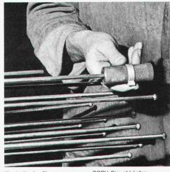
Kontrolle der Abmessungen von BBRV-Stauchköpfen
