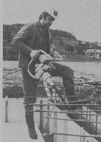
von den besten Hochfrequenznadeln kennt. Der Antriebsmotor ist durch einen Traggriff vor Beschädigungseinwirkungen geschützt.
