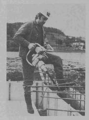
von den besten Hochfrequenznadeln kennt. Der Antriebsmotor ist durch einen Traggriff vor Beschädigungseinwirkungen geschützt.
