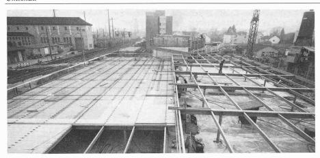
Montageablauf: links Armierung verlegen und betonieren, rechts Montage der Stahlkonstruktion
