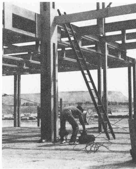
Montage der Deckenelemente
