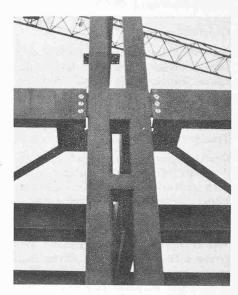
Rand-Detail mit Fassadenwindverband
