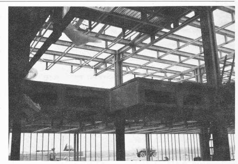
Detail bei Treppenausschnitt mit Spezial-Vierendeelträger
