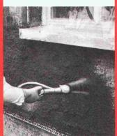
Der rhodipor-Signalvorspritzputz kann mit der Maschine oder
