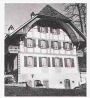
Der Wärmedämmputz eignet sich bei Renovationen hervorragend (Riegelbauten)
