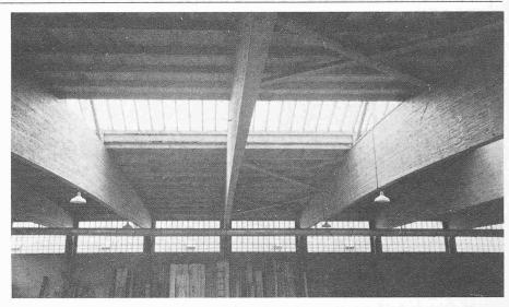
Bild 19. Werkhalle der Caisserie Despond & fils, Bulle, 1937. Stützweite 27 m. Ingenieurbüro J. Barras, Bulle. Diese Biegeträger mit einem Querschnitt von 1,82 m Höhe und 18 cm Breite ohne besondere seitliche Aussteifung dürften zu den schlanksten und höchsten in der Schweiz ausgeführten Leimbau-Querschnitten gehören. (Fotosammlung EMPA-Holz)
