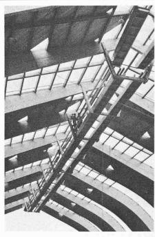
Bild 37. Salzlagerhalle in Schweizerhalle, 1970. Stützweite 34 m. Ingenieurbüro E. J. Schild, Basel. Holzbauunternehmung Häring & Co AG, Pratteln [51], rechts Montagebild
