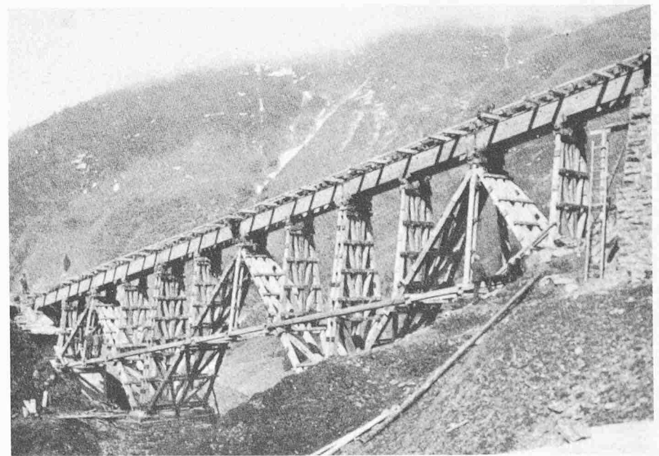
Bild 27. Kühmattobel-Brücke der Brienzer-Rothorn-Bahn, 1942, mit harnstoffharz-verleimten, fast ungeschützten Hauptträgern. Die nach rund 25 Jahren ersetzte Konstruktion wurde jeweils im Winter wegen der Lawenniedergänge demontiert und deponiert. Projekt F. Hübner und M. Cosandey, Lausanne. Holzbauunternehmung Fietz & Leuthold AG, Zürich [22/33]
