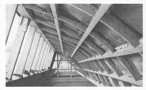
Bild 21. Schalenrost nach E. Staudacher in der Shedkonstruktion einer Industriebaute, 1948. 2 Felder mit je 17 m Stützweite und durchlaufenden Elementen. Jede Shed-Einheit besteht aus einer Rostschale, einem ebenen Rost als Rinnenelement und einem verleimten, ebenen Fensterteil. Ingenieurbüro E. B. Geering, Basel, und Holzbauunternehmungen Osterwald & Bischof, St. Gallen, sowie Gribi & Co. AG, Burgdorf. (Foto EMPA-Holz)
