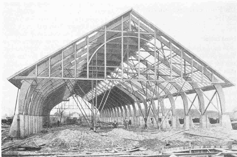
Bild 3. Werkhalle der Zellulosefabrik Attisholz, 1916. Stützweite 25 m [4]
