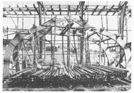
Bild 10. Durch Ch. Chopard vorgenommene Bruchversuche an Dreigelenkrahmen [2]
