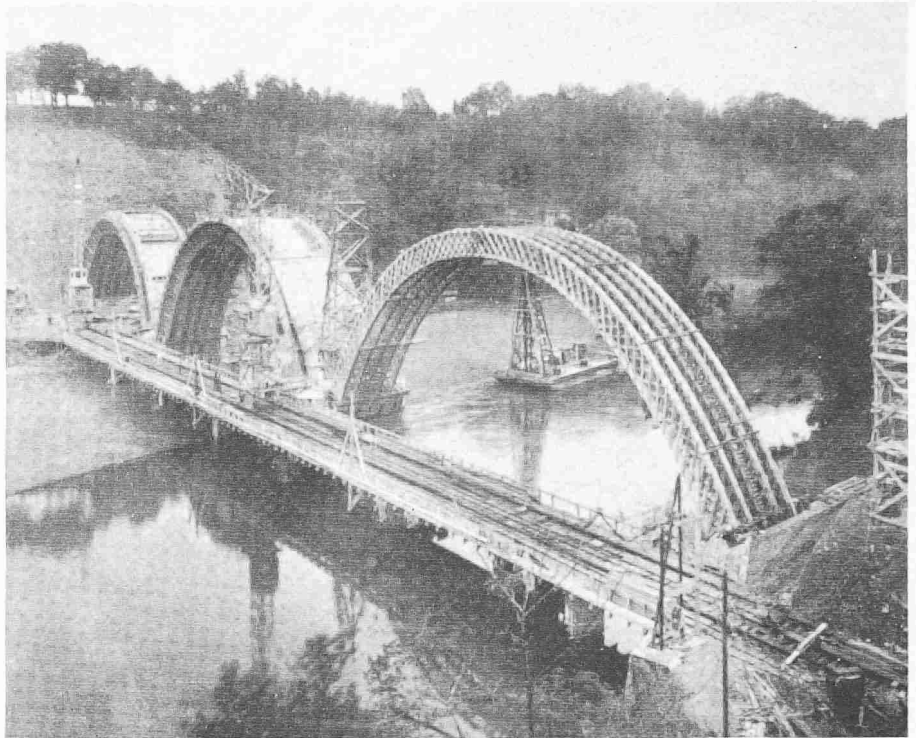
Bild 26. Iehrgerst des Pont de la Jonction, Genf 1944/45. Stützweiten 57,9–52,3–45,8 m mit verleimten Gurten. Projekt SA Conrad Zschokke und Entreprises réunies Pulver-Olivet zusammen mit Locher & Cie., Zürich [22]
