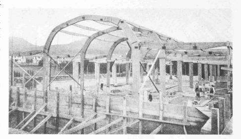
Bild 4. Montagehalle der Maschinenfabrik AG Olma in Olten, 1918. Mittelschiff 18 m, Seitenschiffe je 6,5 m Stützweite. Ingenieurbüro Terner & Chopard, Zürich, und Holzbauunternehmung Nielsen-Bohny & Co. AG, Basel [12]
