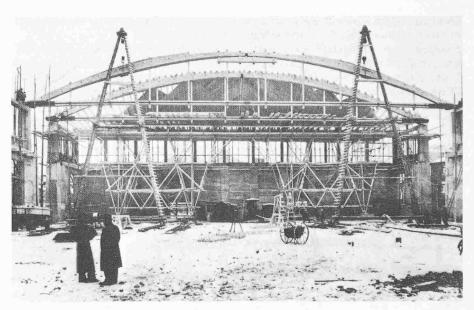
Bild 20. Halle VIII der Mustermesse Basel, 1941/42, bei der Montage. Stützweite 45,5 m. Ingenieurbüro E. B. Geering, Basel, und Holzbauunternehmungen Nielsen-Bohny & Cie. AG, Basel, sowie Gribi & Co. AG, Burgdorf. (Fotosammlung EMPA-Holz)
