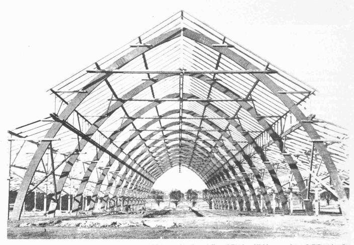
Bild 8. Halle des Eidg. Schützenfestes Aarau, 1924. Stützweite 30 m [9]. Ingenieurbüro Terner & Chopard, Zürich, und Holzbauunternehmung B. Zöllig, Arbon. Die vorliegende Halle wurde 1933 in Bern erneut aufgerichtet. Eine ganz gleichartige Halle war bereits 1911 für das Sängerfest in Küsnacht errichtet worden
