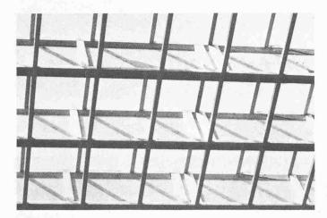
Bild 23. Kämpfsteg-Träger mit faserverschränkten Brettlagen des Steges. Holzbauunternehmung G. Kämpf, Rupperswil [30]
