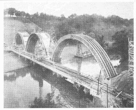
Bild 26. I ehrgerüst des Pont de la Jonction, Genf 1944/45. Stützweiten 57,9-52,3-45,8 m mit verleimten Gurten. jekt SA Conrad Zschokke und Entreprises réunies Pulver-Olivet zusammen mit Locher & Cie., Zürich [22]
