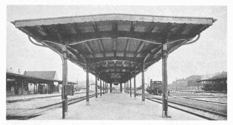
Bild 16. Mehrstieliges Perrondach im Bahnhof Gossau SBB, 1915. Ingenieurbüro Terner & Chopard, Zürich, und Holzbauunternehmung B. Zöllig, Arbon [12]
