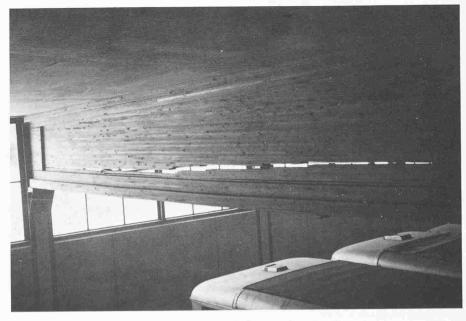
Bild 14. Schubbruch-Schäden an ausgeführten Biegebalken, um 1944. (Foto Hertner)
