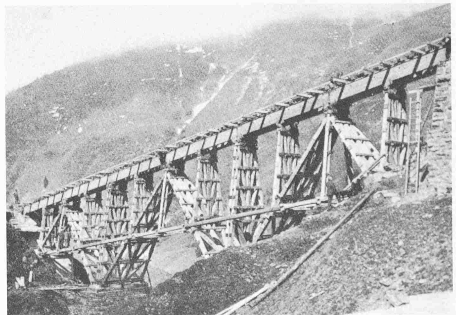
Bild 27. Kühmattobel-Brücke der Brienzer-Rothorn-Bahn, 1942, mit harnstoffharz-verleimten, fast ungeschützten Hauptträgern. Die nach rund 25 Jahren ersetzte Konstruktion wurde jeweils im Winter wegen der Lawinnenniedergänge demontiert und deponiert. Projekt F. Hübner und M. Cosandey, Lausanne. Holzbauunternehmung Fietz & Leuthold AG, Zürich [22/33]
