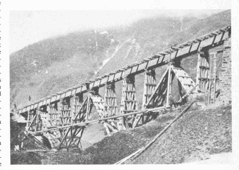
Bild 27. Kühmatttobel-Brücke der Brienzer-Rothorn-Bahn, 1942, mit harnstoffharz-verleimten, fast ungeschützten Hauptträgern. Die nach rund 25 Jahren ersetzte Konstruktion wurde jeweils im Winter wegen der Lawinenniedergänge demontiert und deponiert. Projekt F. Hübner und M. Cosandey, Lausanne. Holzbauunternehmung Fietz & Leuthold AG, Zürich [22/33]
