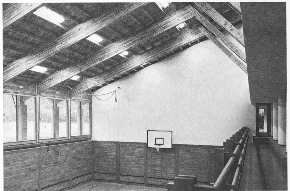
Bild 32. Turnhalle im Ausbildungszentrum «Wolfsberg» der Schweizerischen Bankgesellschaft, Ermatingen 1974/75. Die markante Farbstreifung ergab sich hier aus der ausnahmsweisen Verwendung von Föhrenholz, das im Gegensatz zu Fichte und Tanne eine starke Differenzierung zwischen Splint- und Kernholz aufweist. Architekturbüro R. und E. Guyer, Zürich; Ingenieurbüro W. Menig, St. Gallen; Konsortium von Zimmereifirmen. (Foto LIGNUM)
