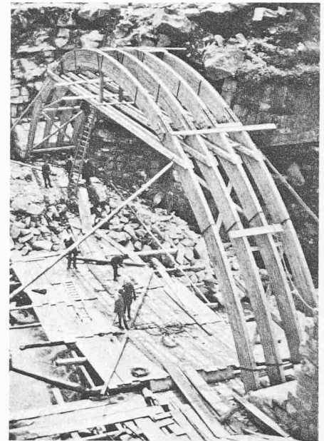
Bild 6. Lehrgerüst für eine Mauerwerksbrücke über die Schöllenen bei Göschenen, 1915. Stützweite 27 m [4]
