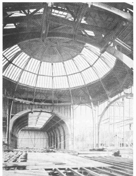
Bild 5. Pavillon «Ernährung», Schweizerische Landesausstellung, Bern 1914. Kuppeldurchmesser 33 m, Stützweite der Hallen-Korbbögen 22 m [4]
