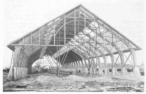
Bild 3. Werkhalle der Zellulosefabrik Attisholz, 1916. Stützweite 25 m [4]
