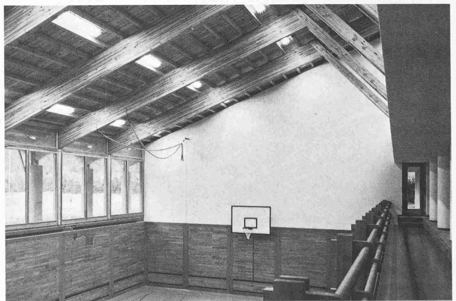
Bild 32. Turnhalle im Ausbildungszentrum «Wolfsberg» der Schweizerischen Bankgesellschaft, Ermatingen 1974/75. Die markante Farbstrreifung ergab sich hier aus der ausnahmsweisen Verwendung von Föhrenholz, das im Gegensatz zu Fichte und Tanne eine starke Differenzierung zwischen Splint- und Kernholz aufweist. Architekturbüro R. und E. Guyer, Zürich; Ingenieurbüro W. Menig, St. Gallen; Konsortium von Zimmereifirmen. (Foto LIGNUM)
