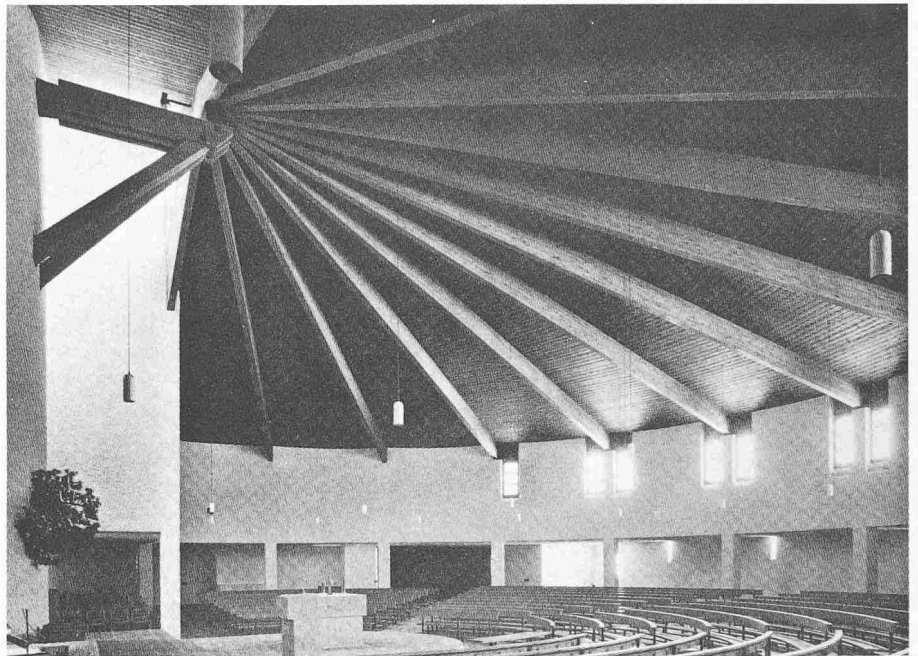
Bild 35. St. Pauluskirche Gossau SG, 1969. Spannweite der Sparren 17,3 m. Architekturbüro Bächtold & Baumgartner, Rorschach. Ingenieurbüro W. Menig, St. Gallen. Holzbaufirma Lehmann AG, Gossau [51]
