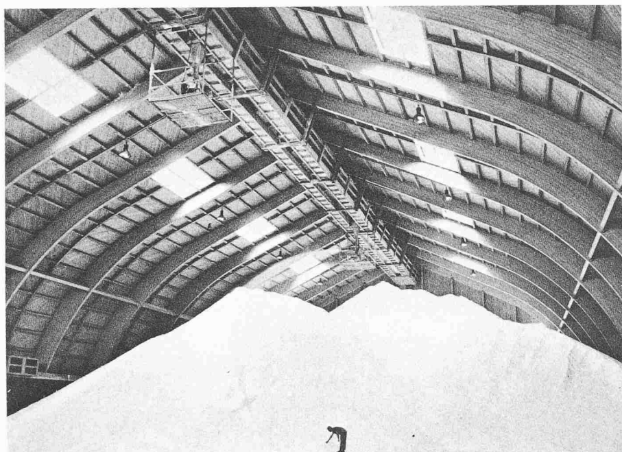
Bild 37. Salzlagerrhalle in Schweizerhalle, 1970. Stützweite 34 m. Ingenieurbüro E. J. Schild, Basel. Holzbauunternehmung Häring & Co AG, Pratteln [51], rechts Montagebild
