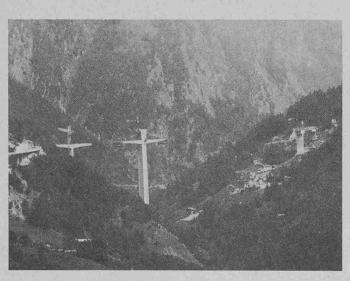
Auf einer Länge von 678 m wird die Ganterbrücke das Gantertal überqueren. In der Bildmitte der mit 148 m höchste Pfeiler 3. Noch nicht sichtbar ist rechts davon Pfeiler 4, der in den geologisch heiklen, linksufrigen Kriechhang zu stehen kommt und deshalb auf einem ca. 40 m tiefen Schacht fundiert wird
