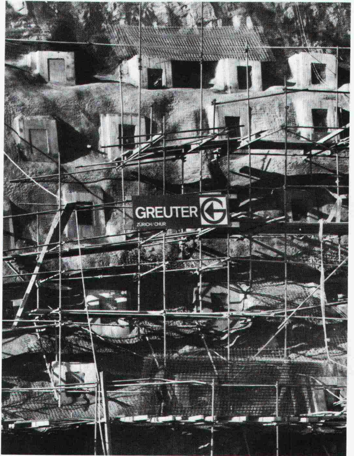
Felssicherung Dangernfluh, N2 (Eptingen)
