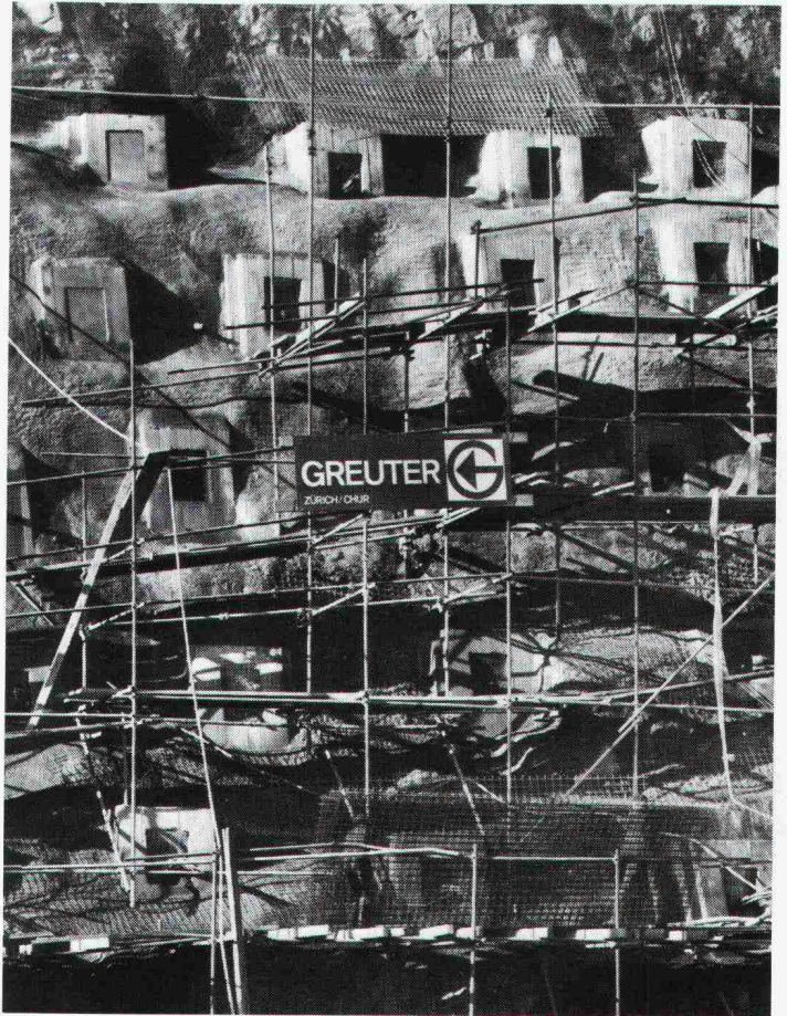
Felssicherung Dangernfluh, N2 (Eptingen)
