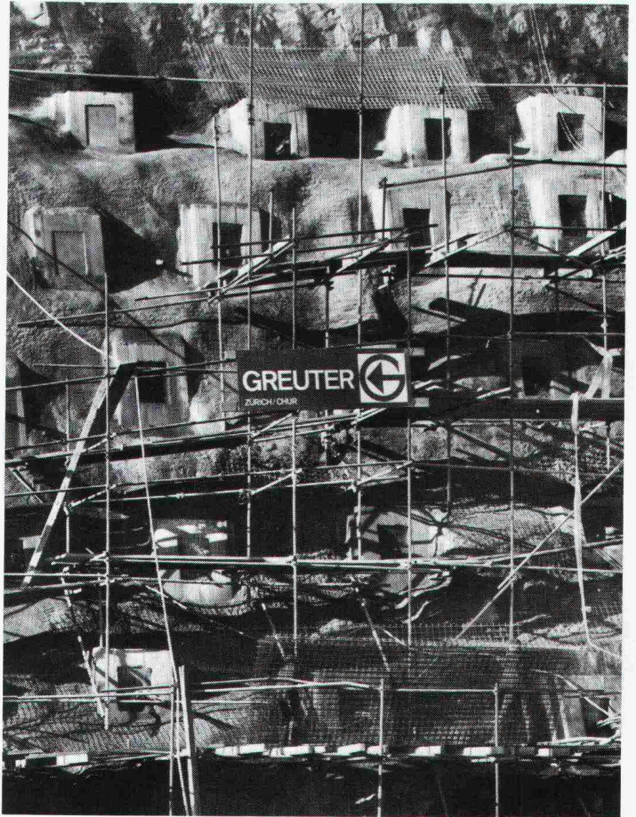
Felssicherung Dangernfluh, N2 (Eptingen)
