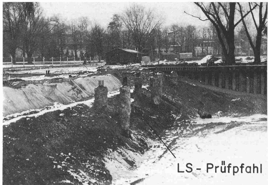
Bild 8. Im Zuge des Aushubs ausgegrabene Zeissl- und LS-Pfähle der Probelastungsversuche. Links im Bild die mit Plastik abgedeckte Böschung des Voraushubs, welcher in der ersten Bauphase zur Ableitung des Schmutzwassers aus der Auffüllschicht diente (s. auch Bild 10)
