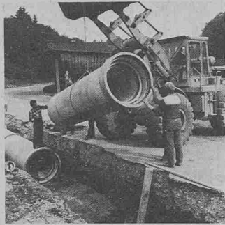
Das Doppelrohr wird in den Graben gebracht, nachdem unmittelbar zuvor das Innenrohr mit Hilfe des Baggers ins Aussenrohr geschoben wurde
