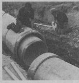
Das Verbinden der Doppelrohre im Graben. Die Konzentrizität der beiden Rohre in der Einbaulage wird durch zwei Auflagerplatten gewährleistet, die an der Kupplung des Innenrohres angebracht sind
