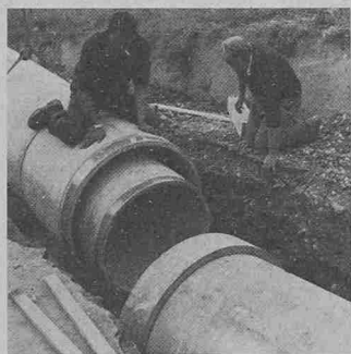
Das Verbinden der Doppelrohre im Graben. Die Konzentrität der beiden Rohre in der Einbauleitung wird durch zwei Auflagerplatten gewährleistet, die an der Kupplung des Innenrohres angebracht sind
