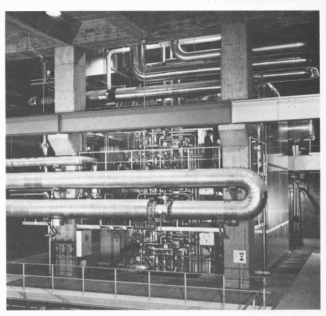
Bild 17. Sulzer-2 Trommel-Strahlungskessel, Frontansicht
