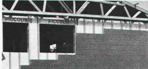
Hochwertiger Glasfaserbeton in der Fassadenausführung (standard) oder (nach Mass). Die hinterlüftete CEMFOR-Fassade setzt neue Massstäbe: Ausserordentlich widerstandsfähig gegen Beschädigung und alle Witterungseinflüsse • Formstabil Nicht brennbar
