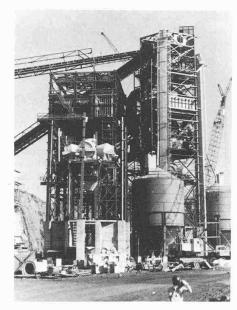
Beton-Aufbereitungszentrale Nr. 2 (im Turm rechts), Eisfabrik und zentrale Lüftkühlanlage (im Turm
