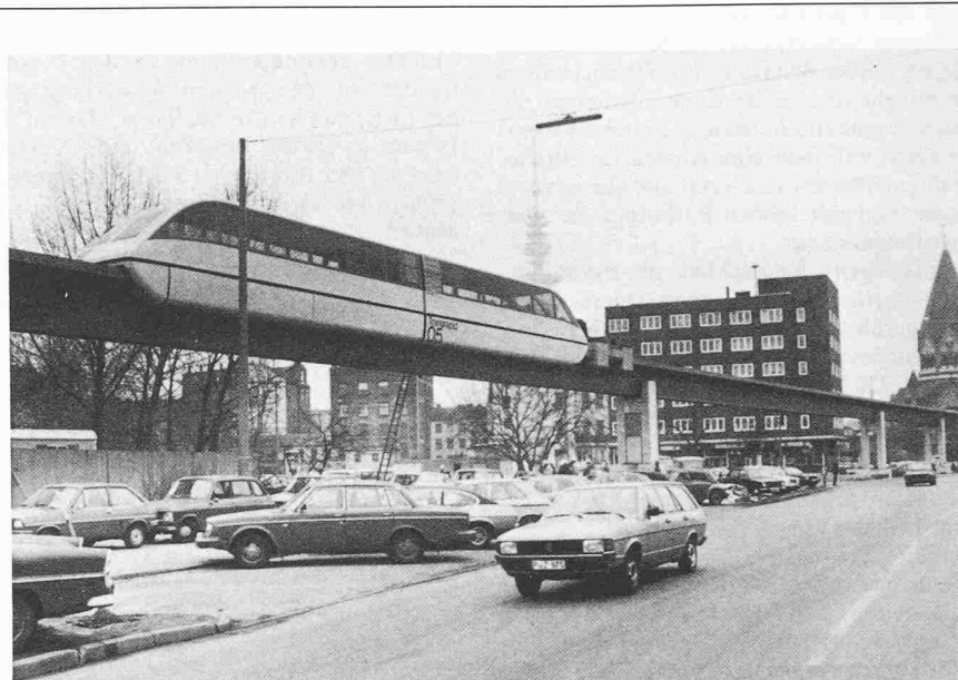
Die Magnetschwebbahn «Transrapid 05» ist eine der Attraktionen der Internationalen Verkehrs-Ausstellung «IVA '79» vom 8. Juni bis 1. Juli in Hamburg. Die Bahn, die auf einer 900 Meter langen Demonstrationsstrecke zwischen dem Messehauptingang Jungiusstrasse und dem Freigelände Heiligengeistfeld verkehrt, besteht aus zwei je 13 Meter langen Triebwagen, wiegt insgesamt 36 Tonnen und kann 68 Fahrgäste befördern. Die Anlage wird mit Förderung des Bundesministers für Forschung und Technologie von der Projektgruppe IVA der Firmen Krauss-Maffei + Messerschmitt-Bölkow-Blohm (MBB) und Thyssen Henschel errichtet.
