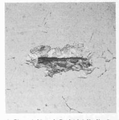
An Rissen eindringende Feuchtigkeit löst Vorgänge aus, die zum Abbau der Alkalität führen. Das verursacht Rostschäden an der Bewehrung. Die Volumenvergrösserung bei Rostung sprengt dann die Betonteile im unmittelbaren Bereich der Bewehrung ab
