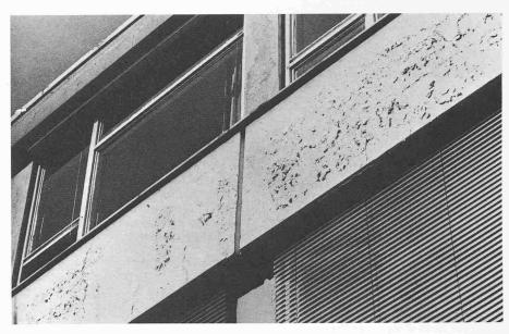
Bei ungenügend abgedeckter Bewehrung entstehen durch thermische Belastungen Volumenveränderungen, die zur Rissbildung führen
