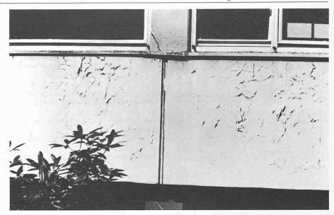
Durch Bindemittelanreicherung in der Oberfläche und unterschiedliche Ausdehnungskoeffizienten von Betonteil und Oberfläche (Sinterhaut) entstehen Risse, die durch einen normalen Anstrich durchgehen und zu Abblätterungen führen
