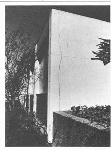
Bei baudynamischen Rissen ist mit ständiger Bewegung zu rechnen. Risse dieses Kalibers sind nur mit doppelter Gewebearmierung zu überbrücken
