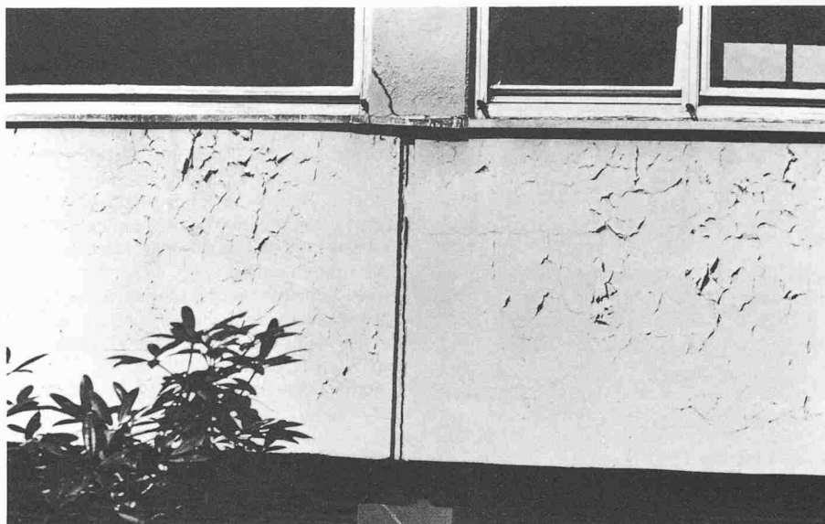
Durch Bindemittelanreicherung in der Oberfläche und unterschiedliche Ausdehnungskoeffizienten von Beton- und Oberfläche (Sinterhaut) entstehen Risse, die durch einen normalen Anstrich durchgehen und zu Abblätterungen führen
